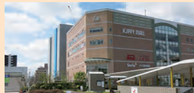
[三田駅前Bブロック地区にビル建設中]
